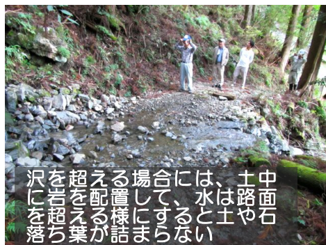
「沢や水路の処理例」
